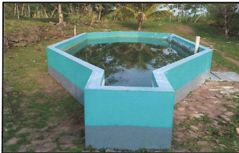
VISTA FOTOGRÁFICA N° 25: Desarenador en Bocatoma de captación
