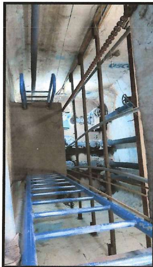
VISTA FOTOGRÁFICA N° 38: Cámara seca, donde están las electrobombas y tuberías
