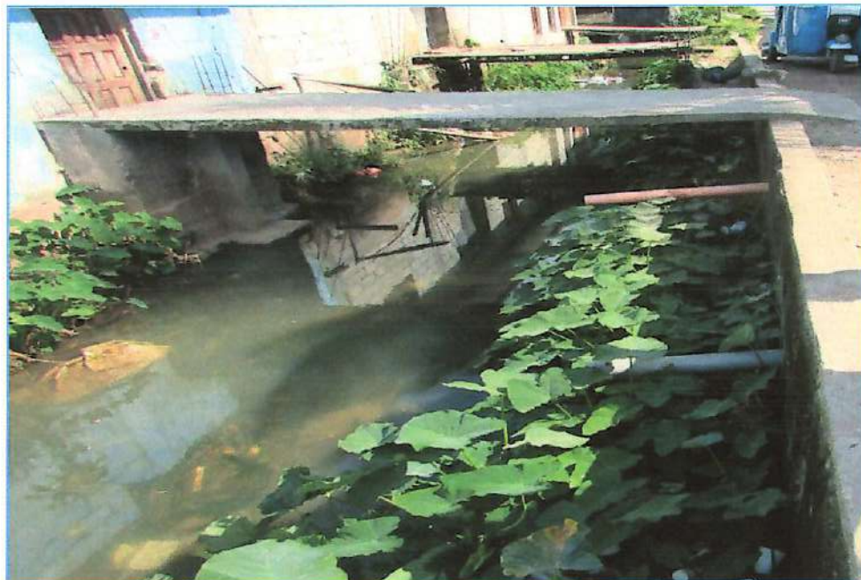
Imagen N°15 Puntos de Desagüe en la Quebrada Cocheros
