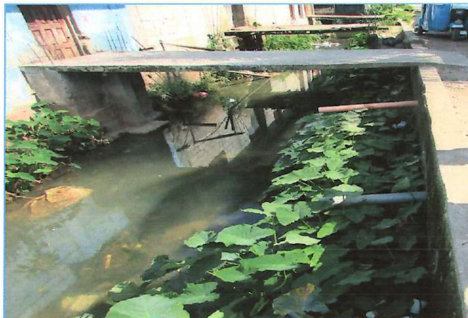
Imagen N°16 Contaminación de la Quebrada Cocheros
