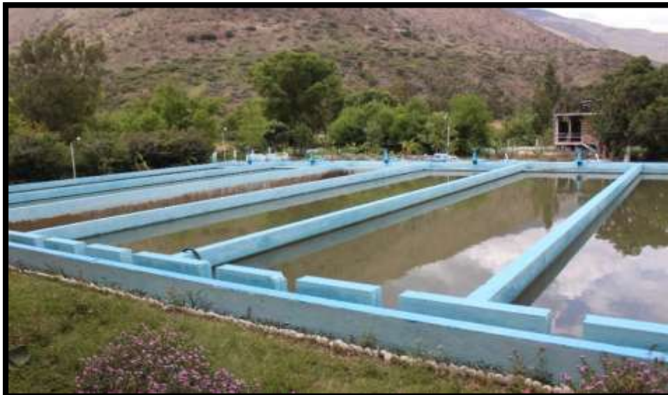
IMAGEN N° 1: PRESEDIMENTADOR DE AGUA
