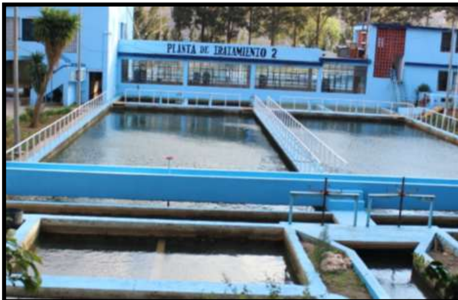
IMAGEN N° 3: PLANTA DE TRATAMIENTO 2
