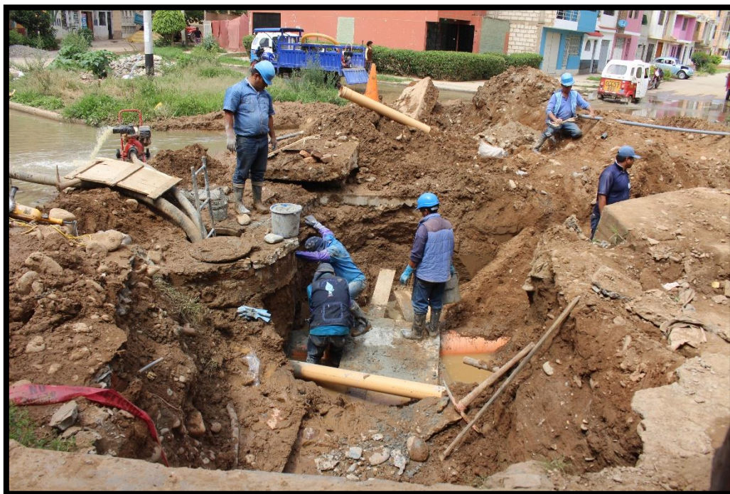
TEMA: TRABAJOS DE MANTENIMIENTO CORRECTIVO DE TUBERÍA MATRIZ
