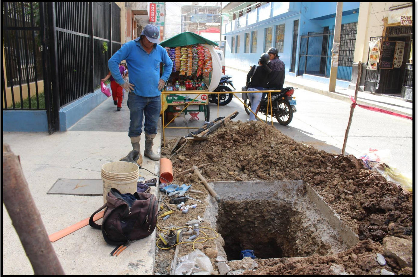
FOTOGRAFÍA: Trabajos de Gestión Operativa en la ciudad de Huánuco.
