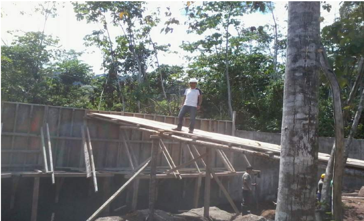
OBRA: MEJORAMIENTO Y ENCAUSAMIENTO DEL RIO TIGRE PARA LA PROTECCION DEL SISTEMA DE CAPATACION DE AGUA
