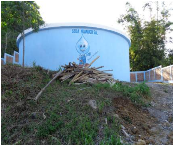
OBRA: CREACION DEL CERCO DE PROTECCION DEL RESERVORIO DE 1,000 M3 JR. MIGUEL
