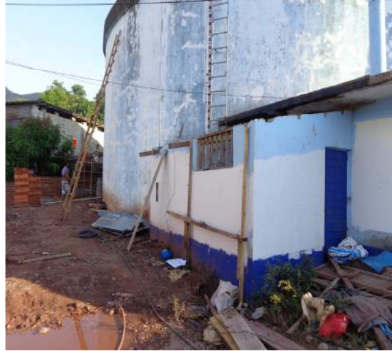
Obra: CREACION DEL CERCO DE PROTECCION DEL RESERVORIO DE 1,800 M3 JR. Lamas
